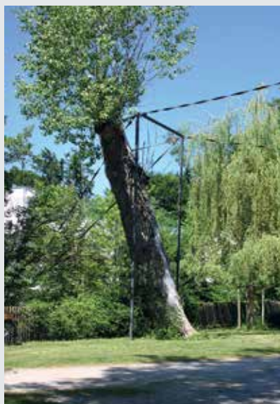
Die Konstruktion stützt den Baum, sollte er an Standfestigkeit verlieren und schützt so im Park Passanten.
